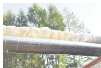
Изоляция сетей с применением изовера, пенополиуретановая скорлупа с оцинкованной сталью
