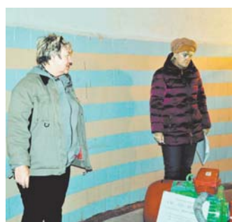
Комиссионный осмотр КНС №4. На фото заместитель генерального директора по эксплуатации Е.Д. Талугина и мастер участка водоотведения г. Тынды А.М. Дудеева
