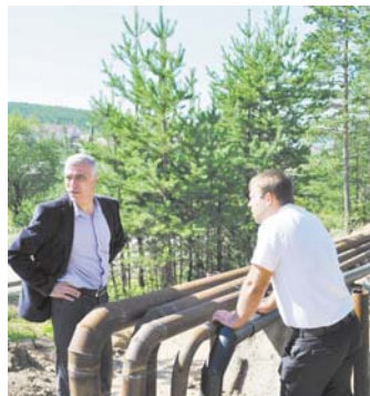
Лето 2016. Замена сетей тепловодоснабжения и водоотведения в микрорайоне Таежный. На фото главный инженер О.В. Завьялов и начальник участка г. Тынды А.В. Гордеев.
