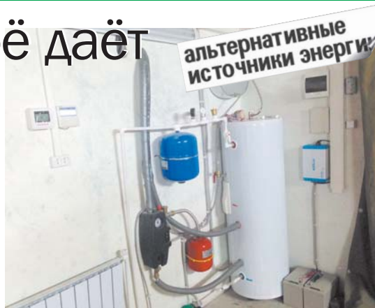
С помощью бака-теплоаккумулятора, установленного внутри помещения, хранится преобразованная от Солнца тепловая энергия
