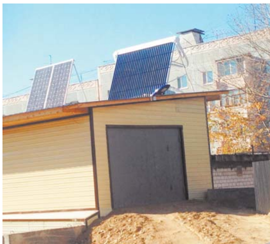
Гараж, обогреваемый солнечными модулями
