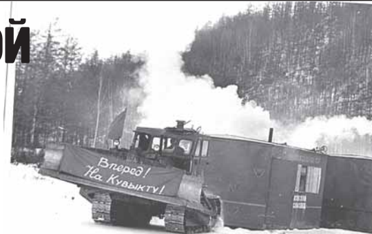
Первый десант строителей на Кувькты (1974 г.)
