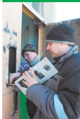
Мастера-наладчики Евгений Подгруппин (на первом плане) и Владислав Рассошных устанавливают панель видеодомофона на дверь подъезда дома № 2 по улице Дружбы
