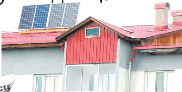
Солнечные батареи на крыше одного из домов в Тынде
