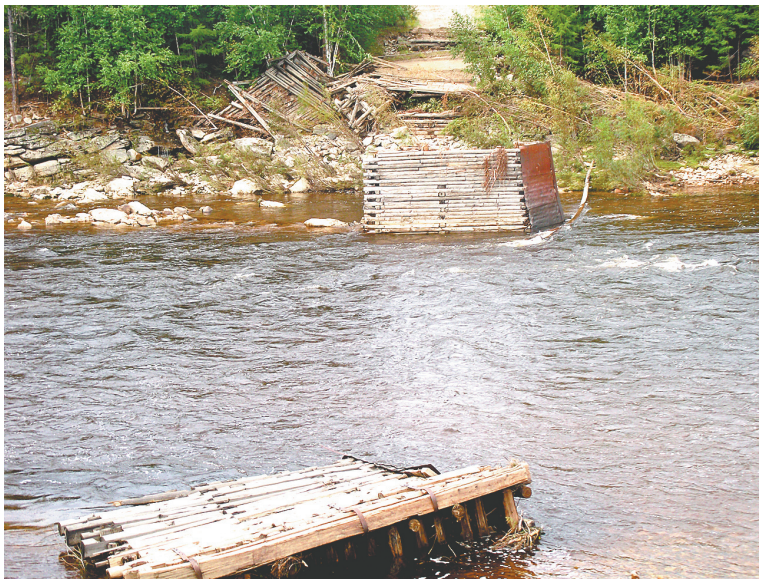
Остатки моста через р. Чильчи
