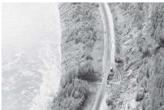
Из-за переувлажнения грунтов в верхних частях склонов существует опасность схода селей на объекты железнодорожной инфраструктуры
