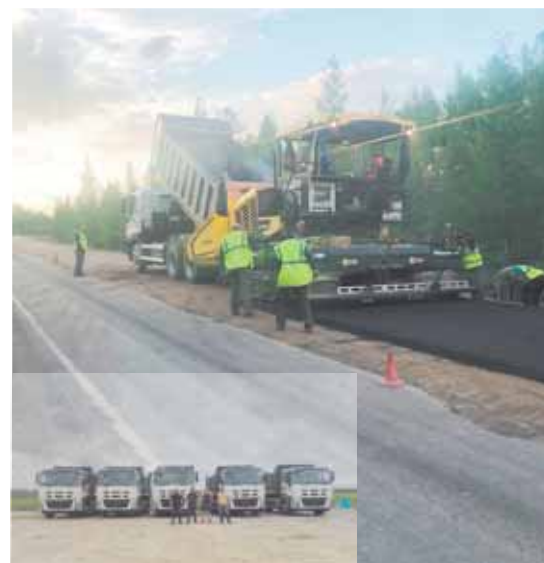
Ремонтные работы на участке федеральной трассы «Лена»
